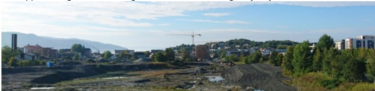
Foto fra planområdet, sett fra øst og nedover Ladalen, sommer 2016.
