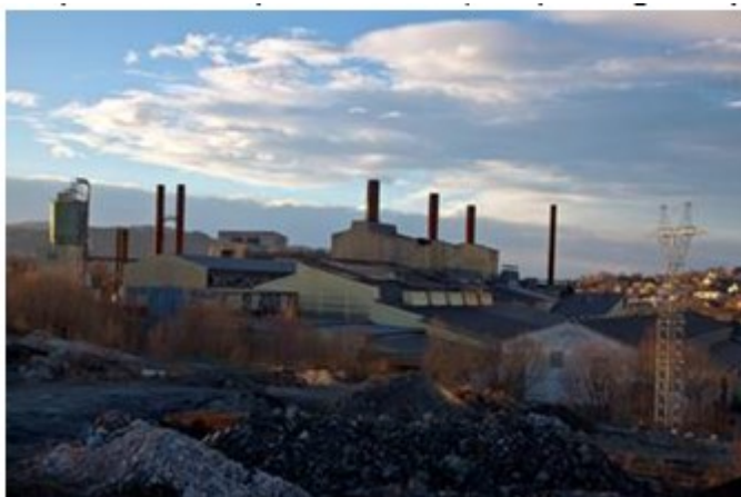
Foto av Lilleby Smelteverk før det ble revet. Pipene viser at bebyggelse på Lilleby historisk sett har hatt en tydelig vertikalitet.
