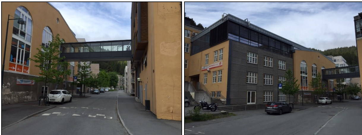
Foto over: sidebygg og gangbro som planlegges revet
