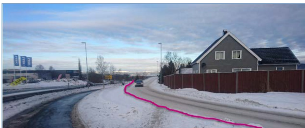
Tonstadbrinken nord har krav om støyskjerm. Støyskjermens plassering er vist med rød strek på bildet.
