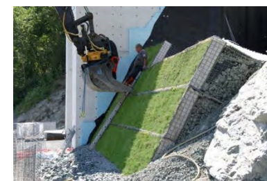
Foto viser gabionmur med grønn front under oppføring.
