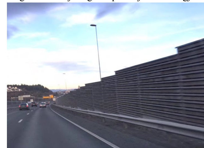
Foto viser eksisterende støyskjerm i Okstadbakken.
