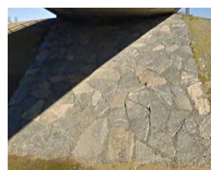
Grøfter langs gs-vegene utformes gjennomgående grønne, også i regnskyggen der gs-vegene passerer under bruene.
