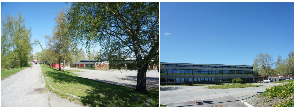
Foto over: Saupstad skole sett fra gang- og sykkelveien i vest og skolen sett fra øst på bildet til høyre
