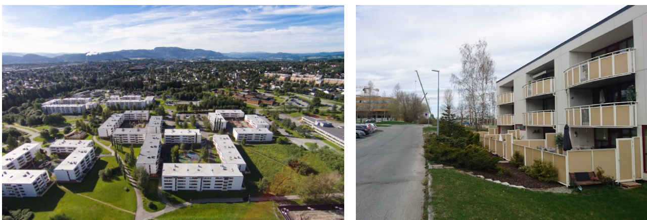
Foto over: boligblokken som er nærmeste nabo i øst og dronefoto (Trondheim kommune) som viser bebyggelsen på Saupstad i dag. Dagens skole til høyre i bildet.
