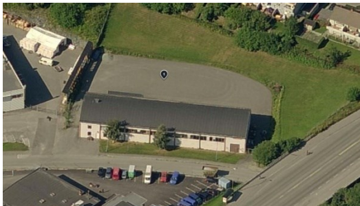
Figur 15: Foto av Ladebekken 15
