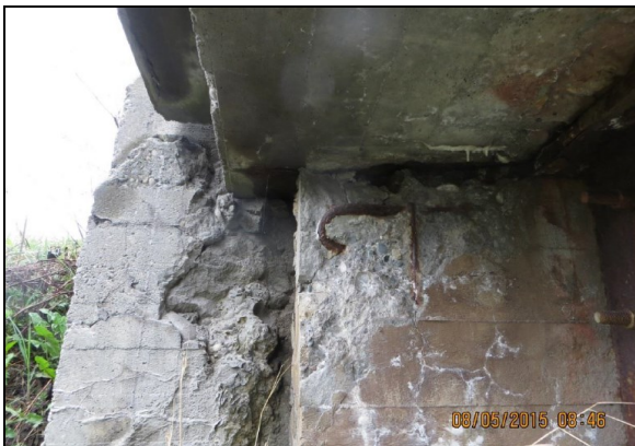
Brå bru sett mot vest. T.h. vestre landkar med omfattende betongskader på landkar og endetverrbejelker.
