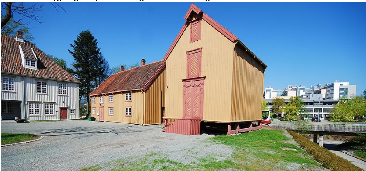
Lerkendal gård med Gløshaugen og gangveien under Leangenbanen. Foto: Bård Magnus Fauske, LINK arkitektur
