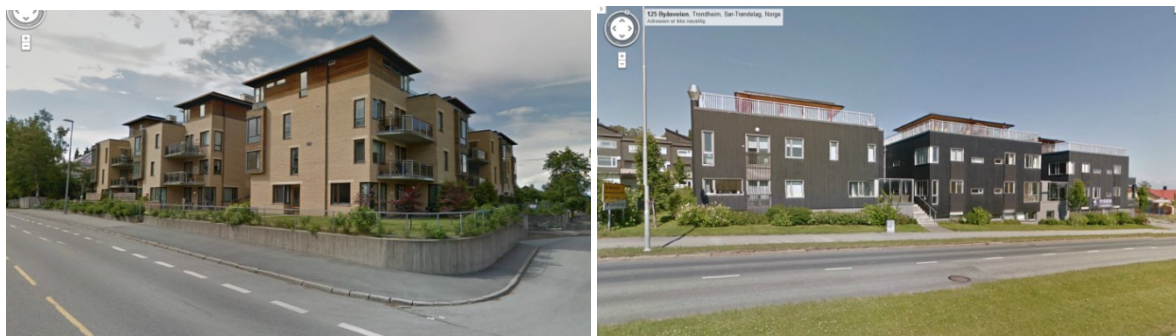
Stadsingeniør Dahls gate 24 ABC har 4 etasjer. Byåsenveien har 3 etasjer og delvis underetasje med næring(dyreklinikk)
