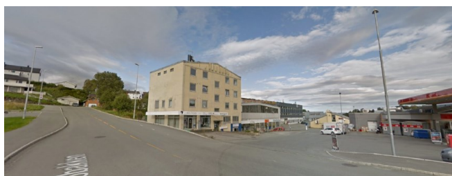
Eksisterende bygninger på tomten midt i bildet. Utenfor reguleringsplanens avgrensning vises bensinstasjon til høyre og Nardobakken med fortau i forkant.
