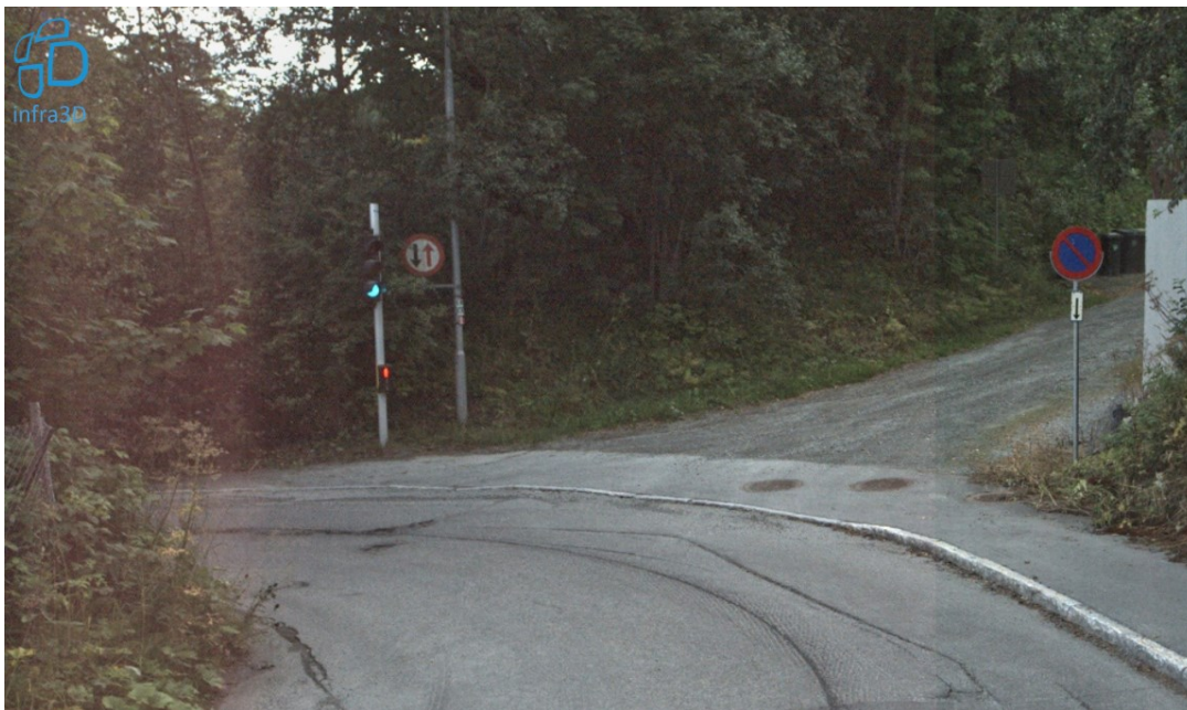
Figur 1 Eksisterende avkjørsel mot Selsbakkvegen
