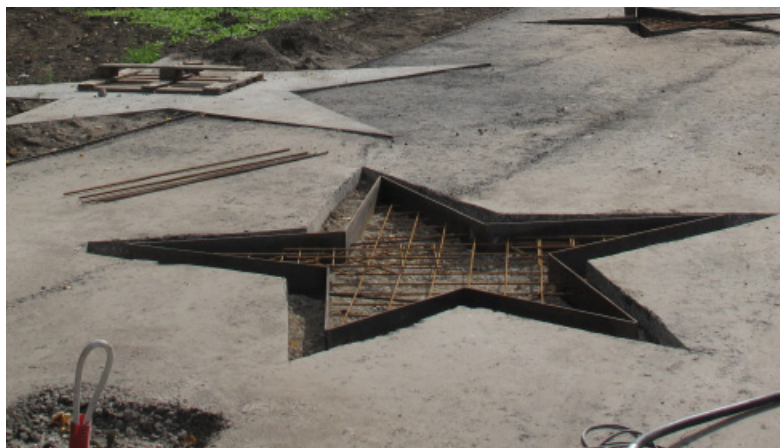
Prinsipp for støping av betongfelter i asfalt. Byggeplassbilder fra Nordvestparken, København.
