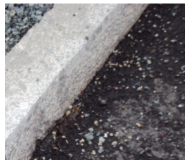
Kantstein ved kjøreveg
