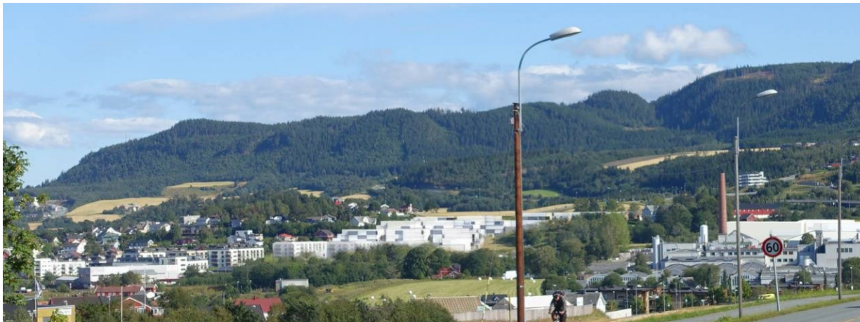
Fjernvirkning, sikt fra Askeladdvegen bussholdeplass.
