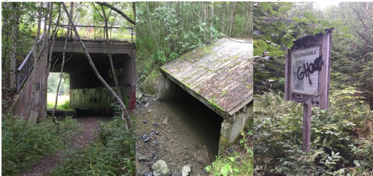
Ved Hårstadbekken er en kulvert som går under Tiller-ringen, et utløpsbygg for dagens overvannsledning og et infoskilt.
