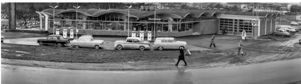
Anlegget uten det store pumpetaket, som kom til i nyere tid.
