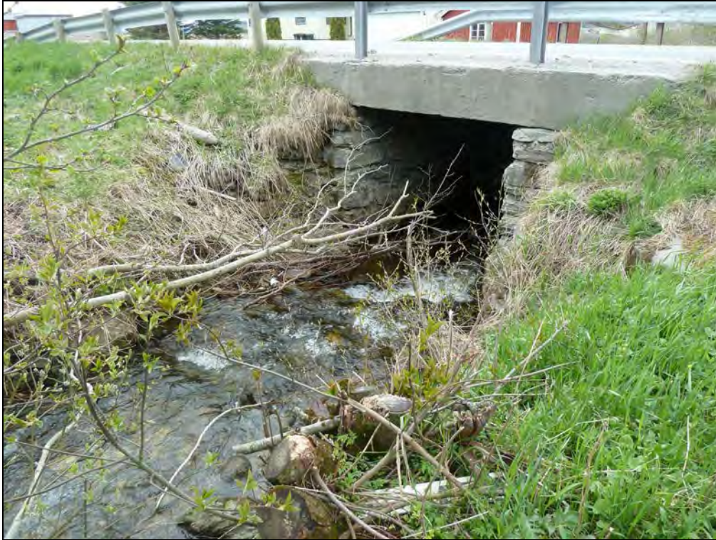
Figur 3: Innløpet til eksisterende kulvert i Kvisetbekken.
