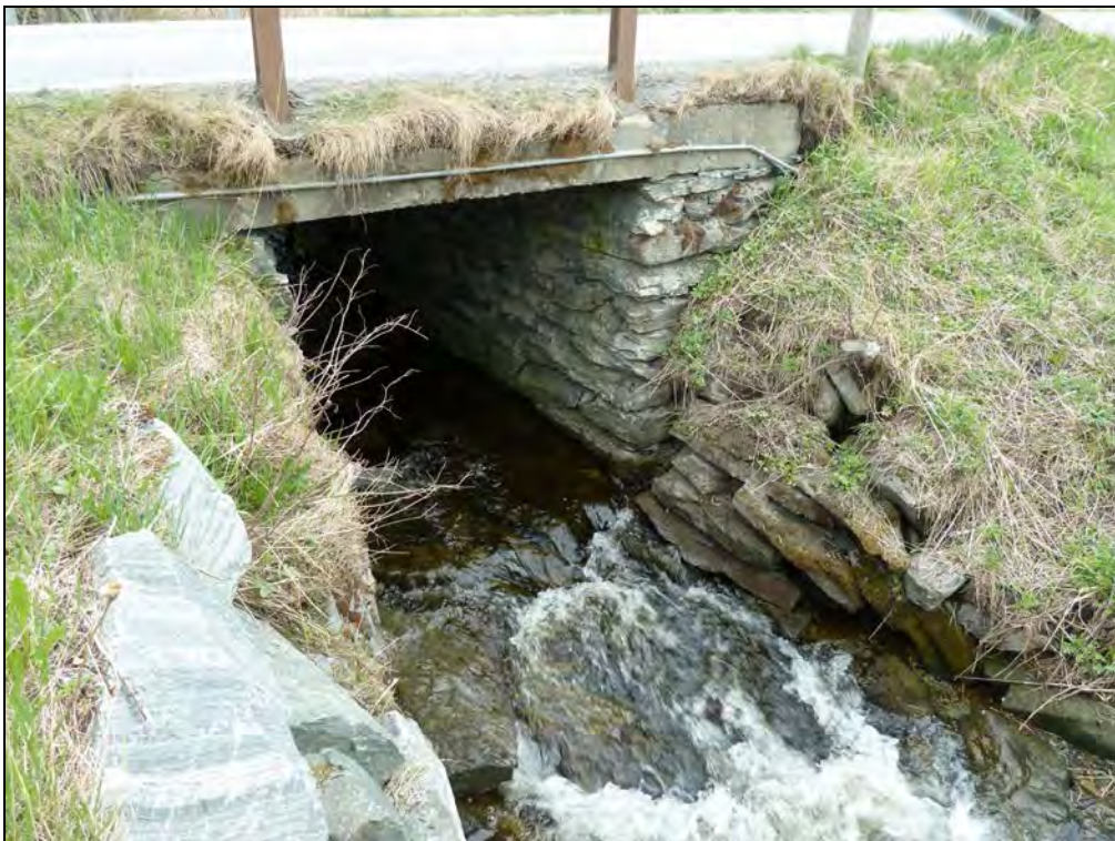
Figur 4: Utløpet til eksisterende kulvert i Kvisetbekken.
