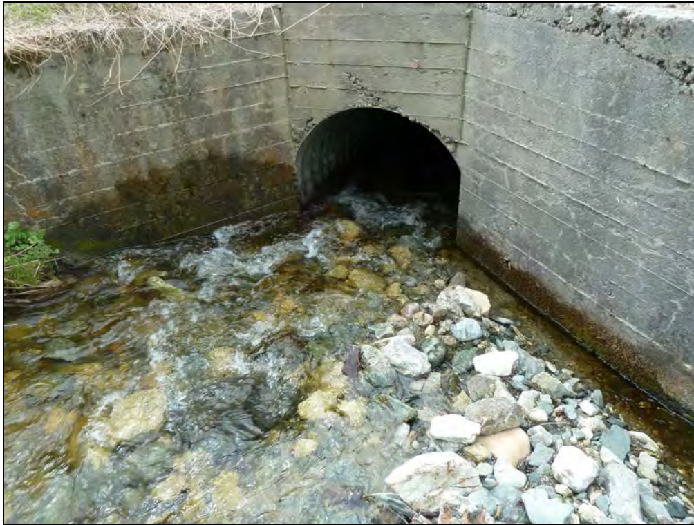
Figur 5: Innløpet til eksisterende kulvert i Skirna.
