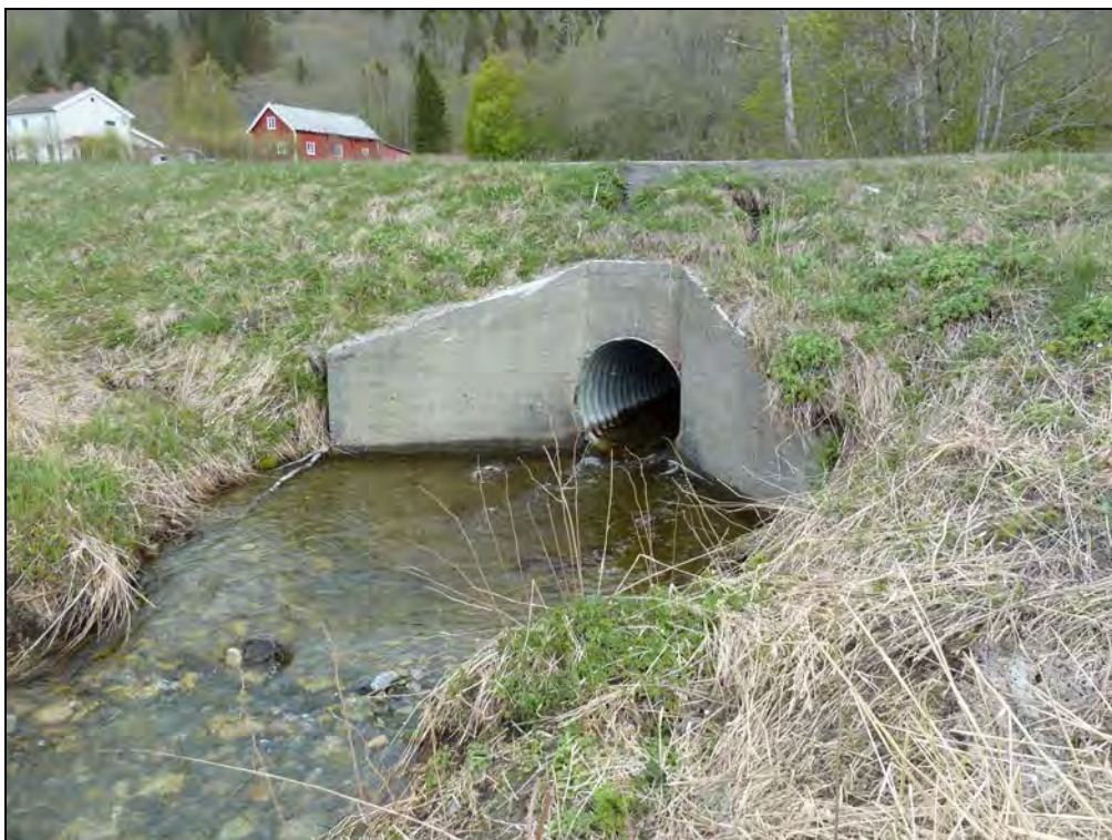
Figur 6: Utløpet til eksisterende kulvert i Skirna.
