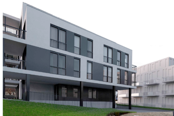
BB2, Gildheimsvegen 10A, redusert til fire etasjer (fjerde etasje er tilbaketrasket). Sett fra inngangen til eksisterende bolig i Gildheimsvegen 10B.
