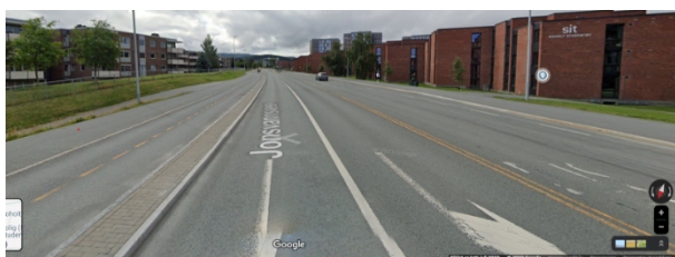
Jonsvannsveien, eksempel på trafikkdel uten trær
