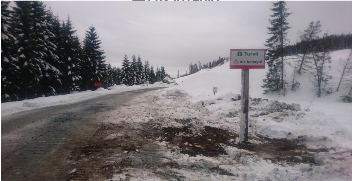
Anleggsvei mot sør
