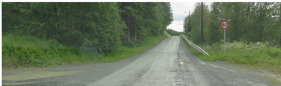
Figur 15 Sikt mot fra avkjørsel mot bakketopp.
