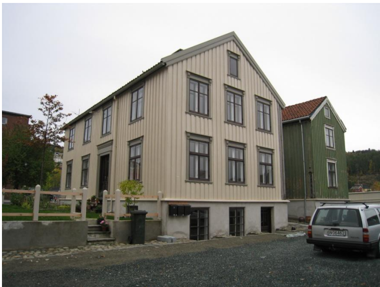
Figur 28. Langvolden ble bygget ca 1850, flyttet i 2005, og istandsatt av arkitektene Bente Egeland og Trond Eide. Originale bygningsdeler er istandsatt og bevart. Fra å være helt nedslitt, er huset nå et praktbygg. Foto: Arkitektene
