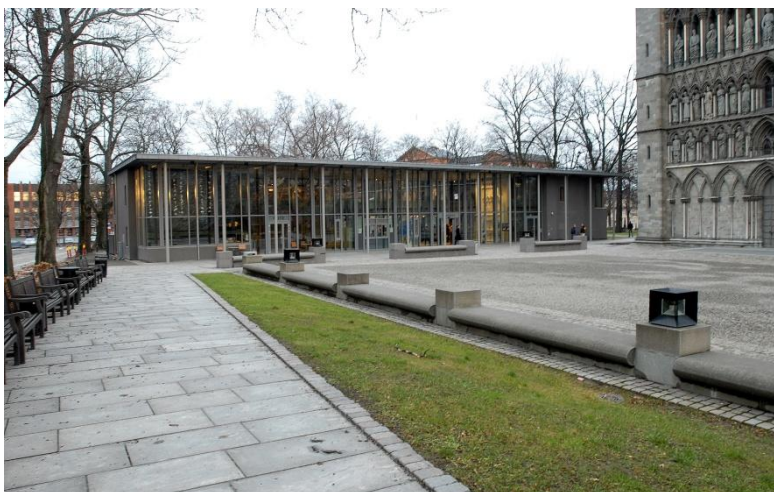
Figur 36. Nidarosdomens besøkssenter. Eggen Arkitekter sier at de var opptatt av å spille opp mot kirka. Søyleraden foran besøkssenteret skaper samspill med de smekre søylene i kirkas fasade. Foto: Trondheim kommune
