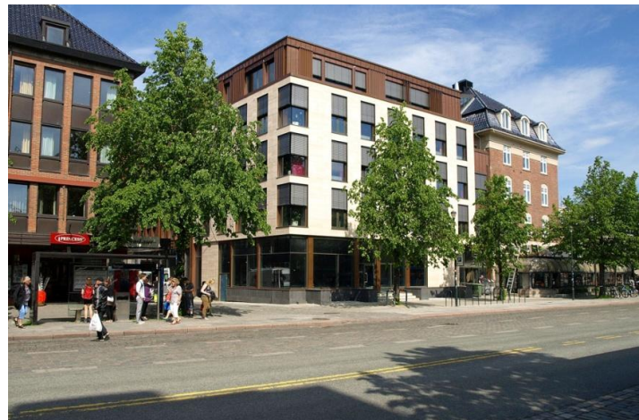
Figur 25. Residencekvartalet. Eiendommen har stor synlighet fra Torvet, Trondheims viktigste byrom. Bygningen følger den historiske byggelinjen og utformingen bidrar til å skape en helhet i gatebildet. Arkitekt: Svein Skibnes. Foto: Trondheim kommune.
