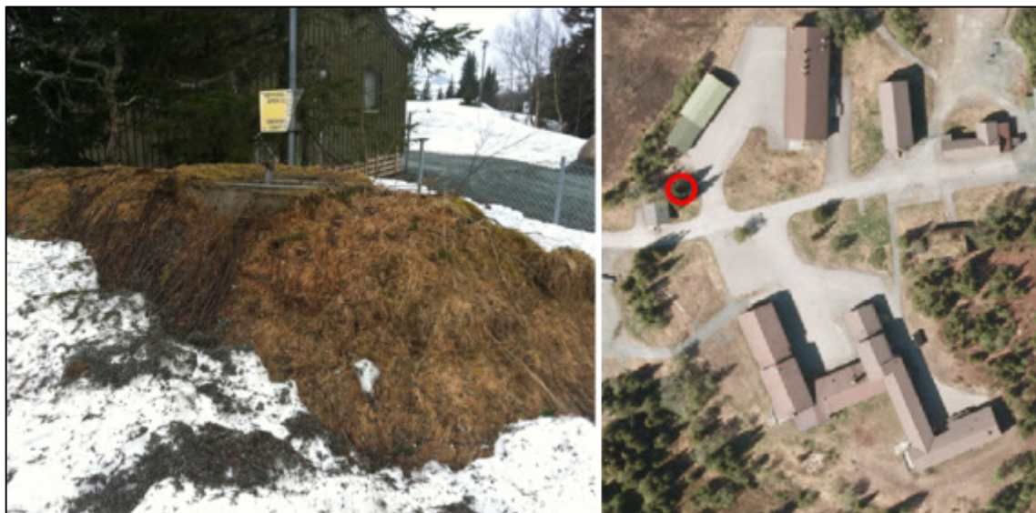
Figur 4: Gammel delvis nedgravd fyringsoljetank (4 m 3 ) som ikke er i bruk
