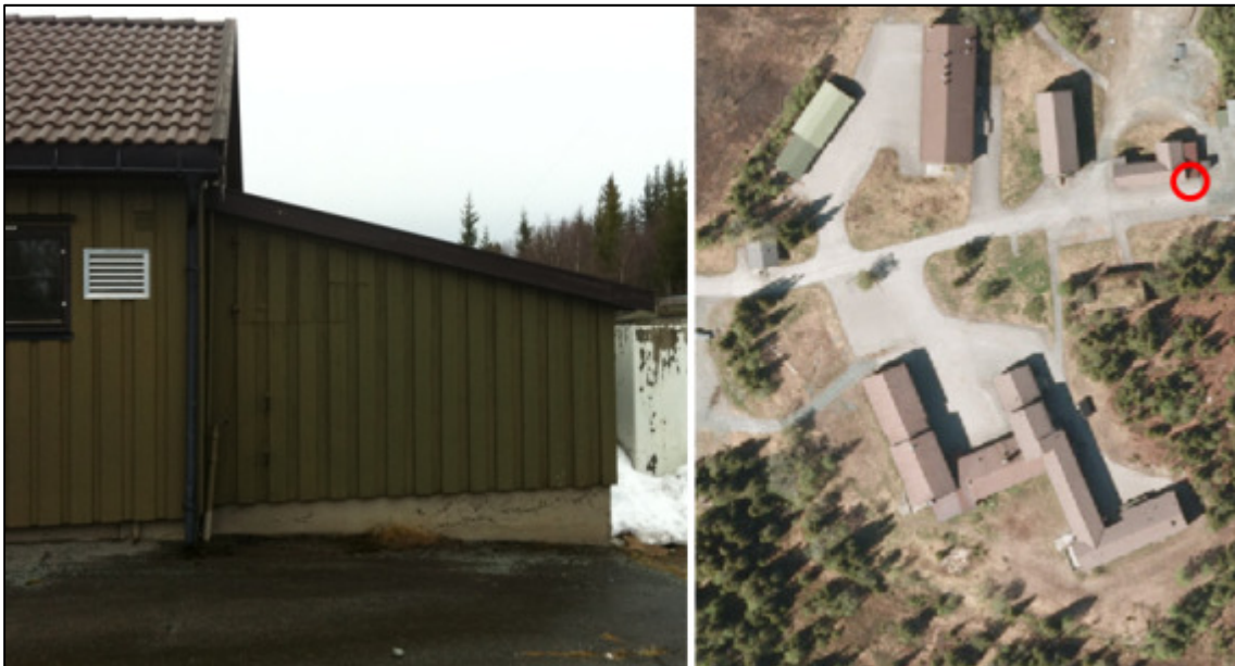
Figur 6: Fyringsoljetank (ca. 6 m 3 ) inntil maskin/snekkerverkstedets-bygningen
