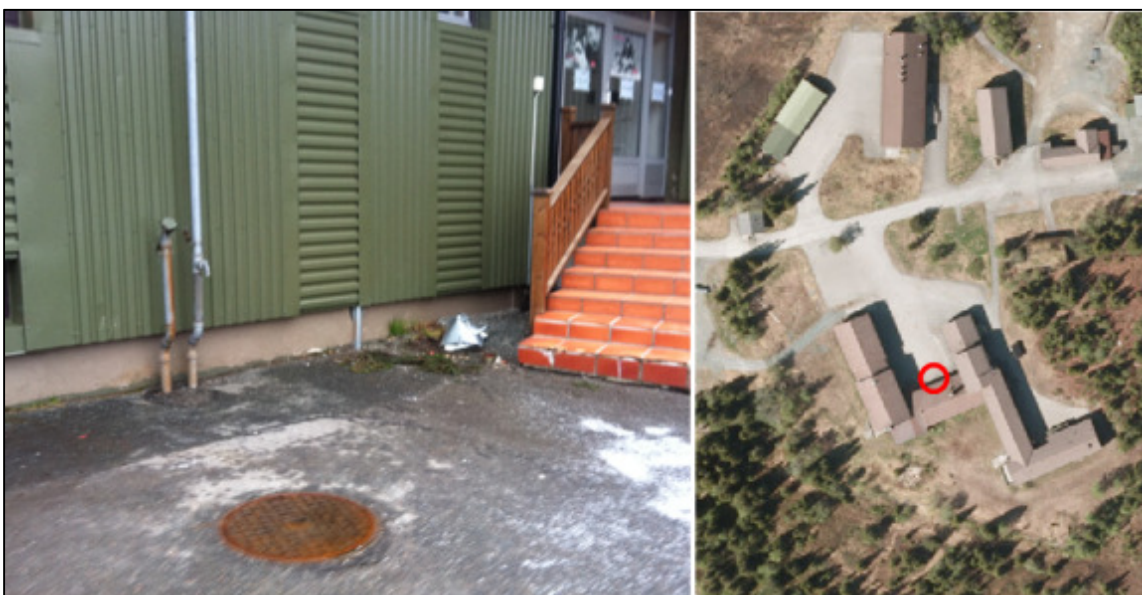
Figur 3: Fyringsoljetank (6 m 3 ) inntil det tidligere forlegnings- og messebygget
