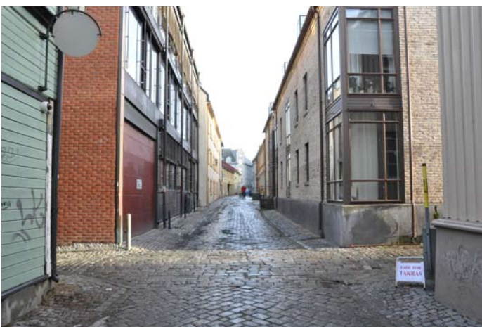
Nyere og eldre bebyggelse som skaper tydelig avgrensning av gaterommet som Brattørveita utgjør. At nybygg følger den historiske eiendomsstrukturen og forholder seg til eksisterende høyder, viser hensyn til trehusene.
