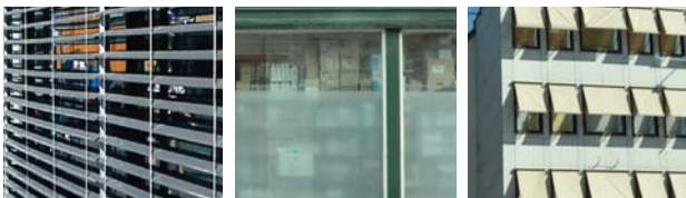
Fasadenes utforming påvirker byrommene. Mørke persiennner og folie lukker bygningen mot gata. Markiser kan virke mer åpent.
