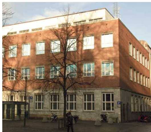
Telegrafens bygg i Kongens gate. Tilbaketrukket toppetasje er nøytralt utformet og lar hovedfasaden dominere.
