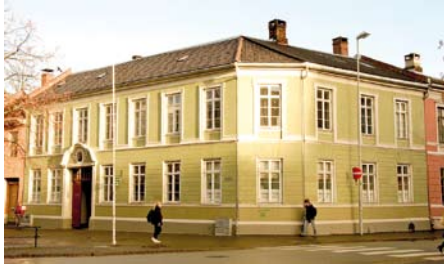
Tradisjonelt skråskjært hjørne på kvartal i Munkegata.
