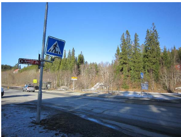
Gangfelt over Kongsvegen med nedslitt oppmerking
