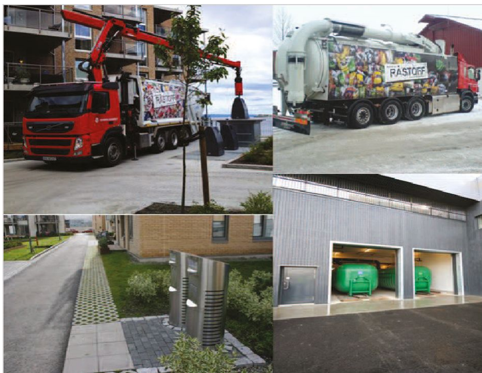
Figur 12: Eksempler på utstyr og installasjoner i forbindelse med nedgravde oppsamlingsløsninger. På bildet øverst til venstre er det kranbil som tømmer nedgravde containere. På bildet øverst til høyre vises bil for tømming av mobile avfallssuganlegg. På de to nederste bildene ser man nedkastpunkt og stasjon med containere i et stasjonært avfallssuganlegg. Foto: TRV/Trondheim kommune.
