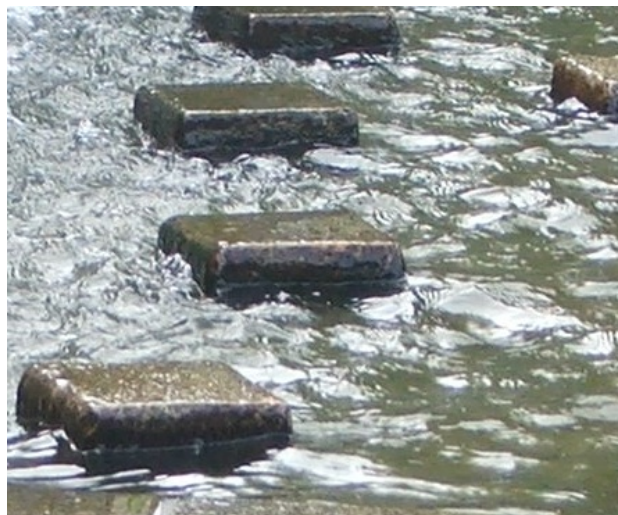
Figur 32. I kanal kan det legges inn ulike tiltak for å variere strømningsforholdene og for å samle vannet ved lav vannføring. Det vil også bidra til bedret vannkvalitet og gi en variert opplevelse av vannet.
