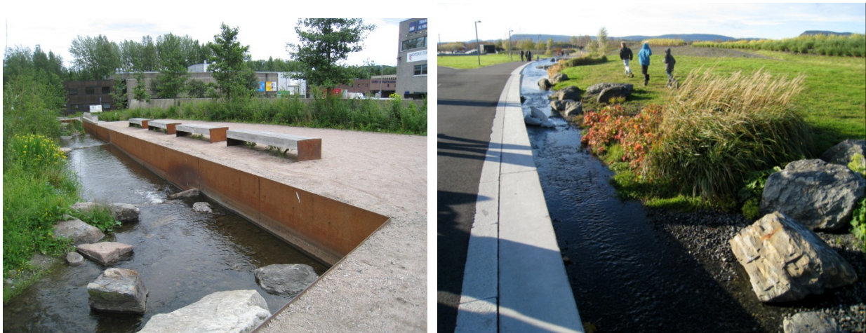
Figur 27. Urban/stram utforming på ene siden av bekken på deler av området. (Kanten kan ikke ha så presis avslutning som kantene på bildet over pga. setningsfare).
