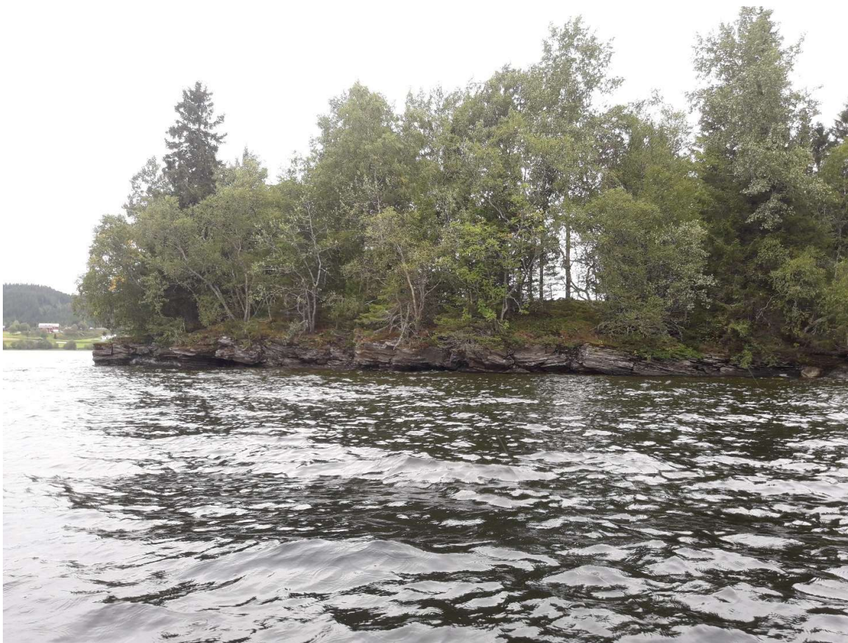
Figur 3-3. Nordre landfeste sett fra Stortvatnet ved vannstand HRV – 0,32 m. Byggested for flom- og tappeløp dam Valen En plantegning av flomløp og tappeløp er vist på figur 3-4.
