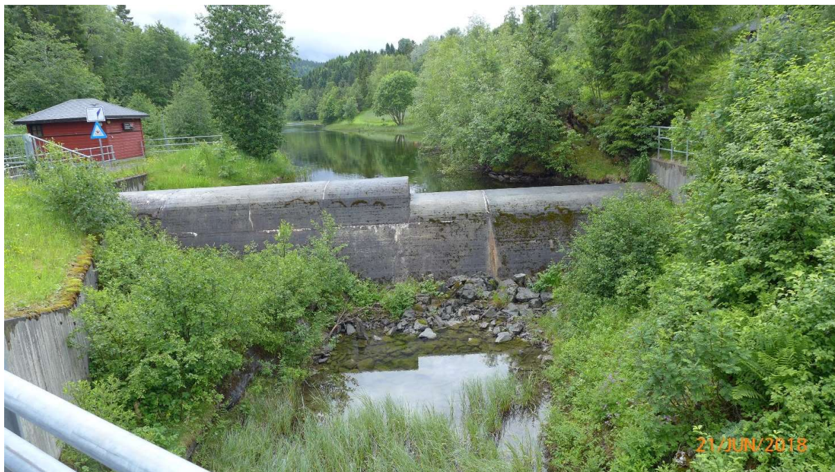
Figur 3-6. Dam Osen sett fra nedstrøms side
