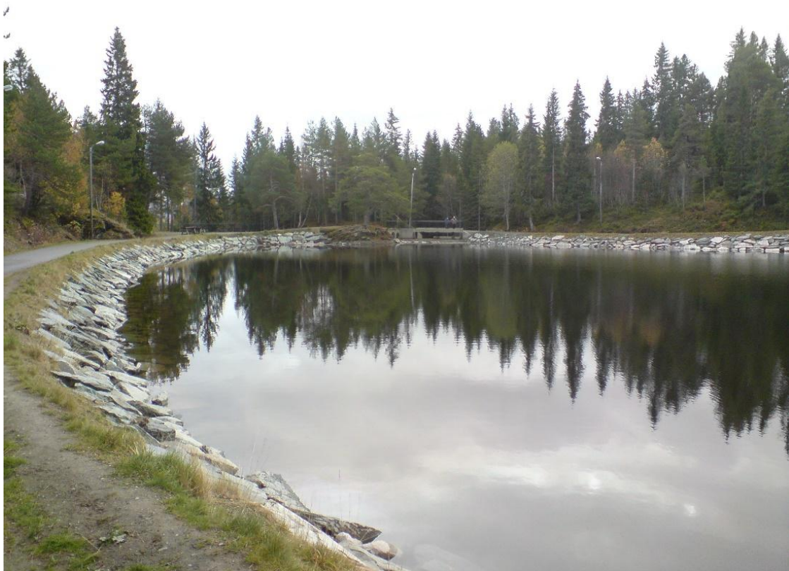
Dagens demningen med overløpet til høyre. Breddene er plastret med stein for å hindre erosjon. Foto: Bjørn Brenne (privat).
