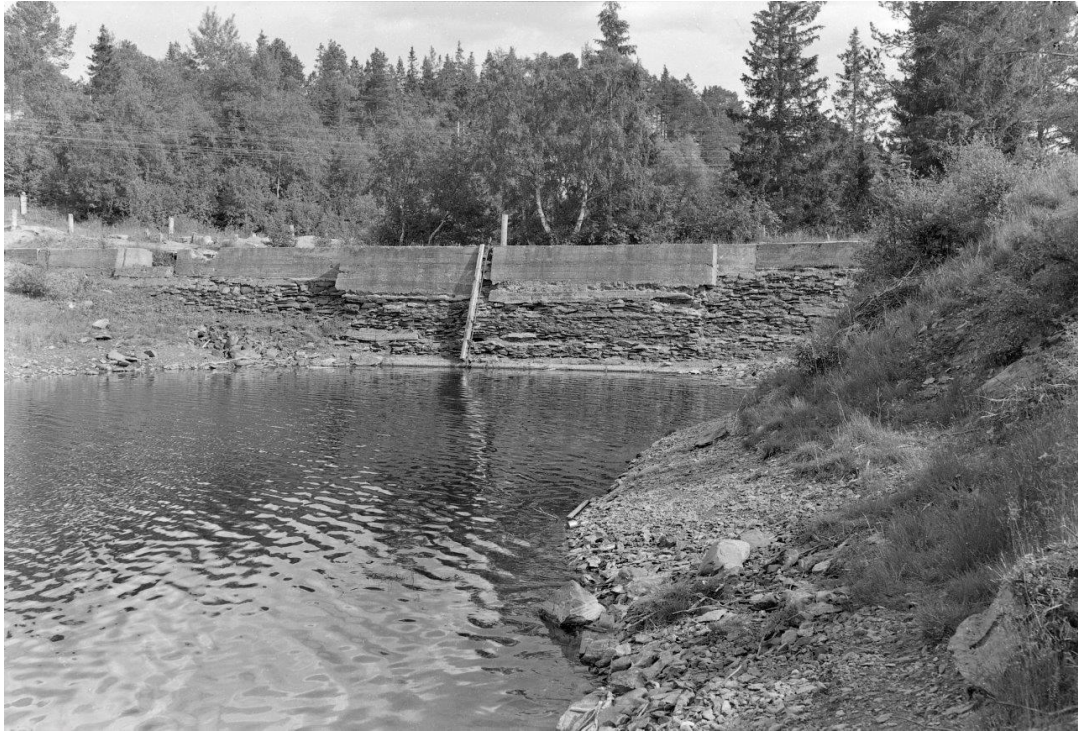
Kyvatnet nedtappet for vedlikehold av demningen, med den gamle steindemningen i bunnen og påstøpt krone. Schrøderarkivet – Sverresborg Trøndelag Folkemuseum.
