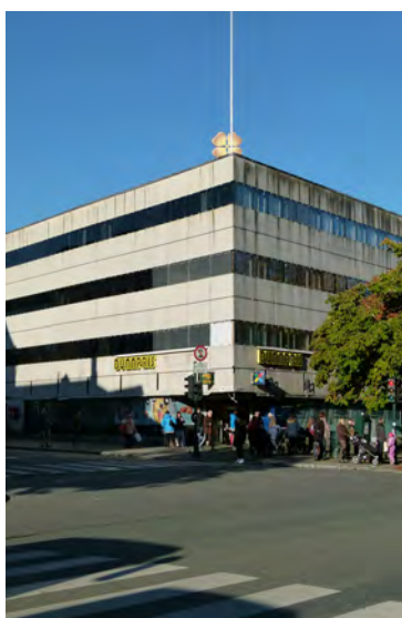
Dagens Lykkegård, oppført i 1972, arkitekt Herman Krag. I 2012 planlegges ny fasadekledning.
