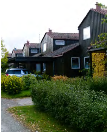
Frydenbergveien. Kjedehusbebyggelse fra tidlig 1960-tall, der arkitektur, gode boligplaner og et kvalitetsfylt uteromsmiljø til sammen utgjør et meget verdifullt kulturmiljø.
