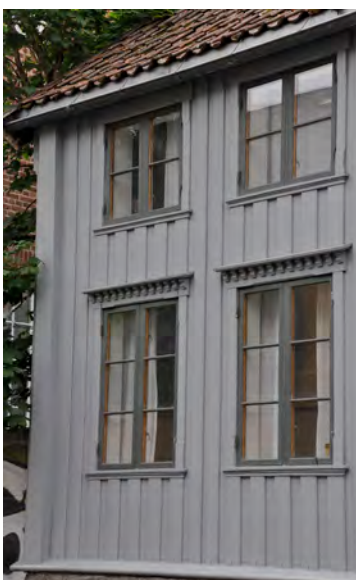
Opprinnelige detaljer, som vinduer med kittfals, har betydelig historisk og estetisk verdi. Forsviner detaljene går verdiene tapt.
