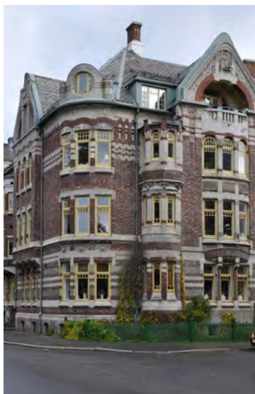
Arkitekt Christies gate 4c er fredet. Bygget er tegnet av Johan Osnes og oppført i jugendstil i 1904.
