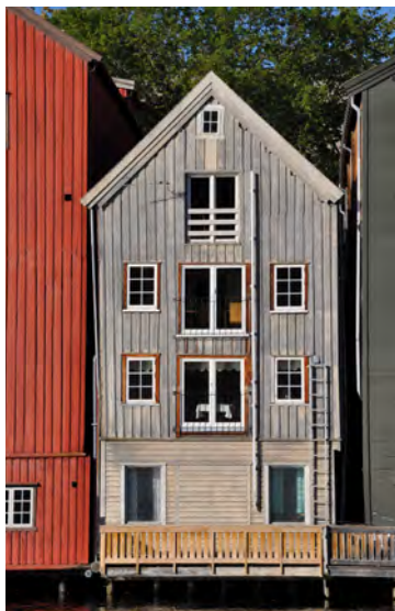
"Lillebryggen", Kjøpmannsgaten 21, har fått ny bruk i alle etasjer - restaurant i første, og kontorer i etasjene over.
