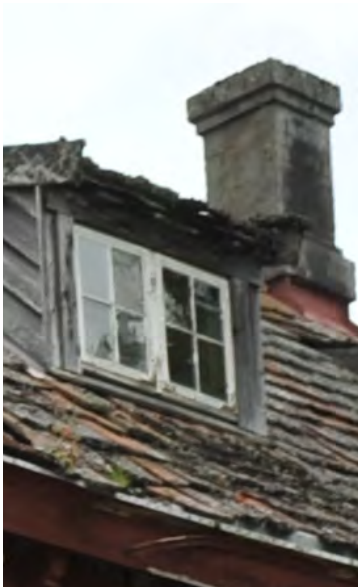
Sommerseter er et eksempel på at det er behov for økte bevilgninger til vedlikehold av den mest verdifulle eldre bygningsmassen.
