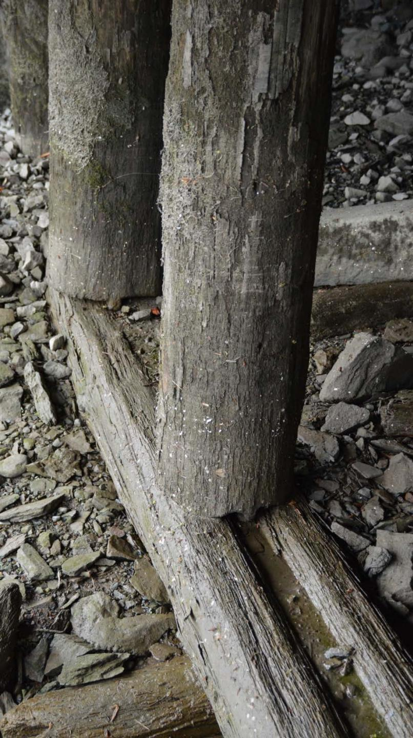
Stolpane står i slisk med spor. **Dei er til å skifte ut.** Tømmeret som ligg meir eller mindre konstant under vatn held lenger enn det som er halvrått heile tida og som dertil får mekanisk slit av isgang.
