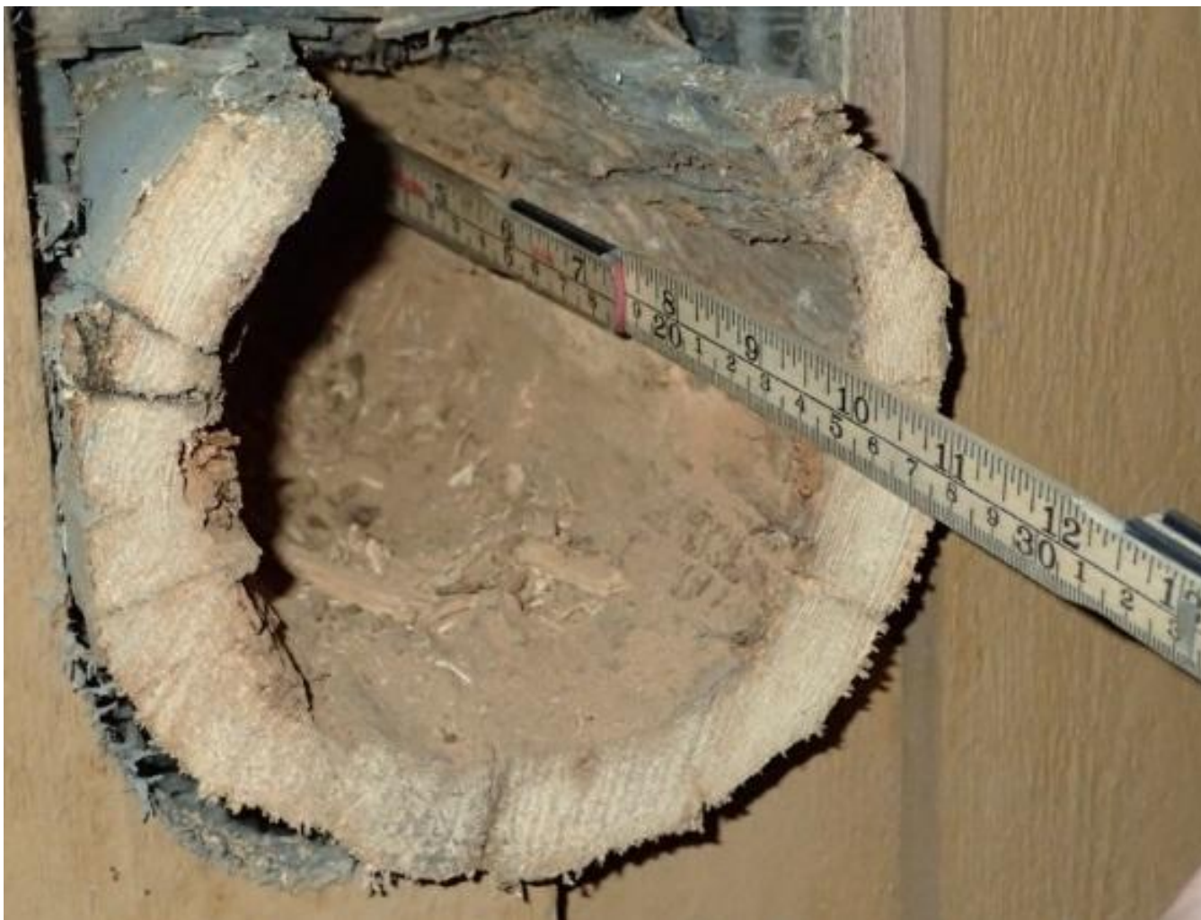
St Jørgensveita 2. Utkraget bjelke før reparasjon.
