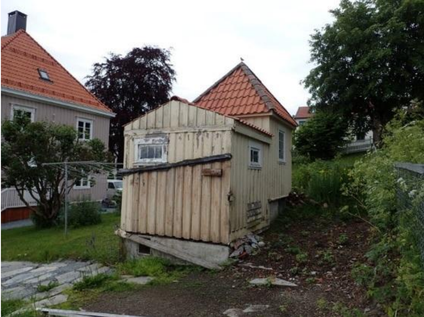
Steinberget 14. Hagepaviljong under arbeid i 2016
