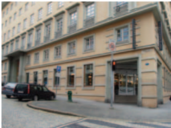
Hovedfasade mot Valkendorf gate med hovedinngang på hjørnet Foto: CUBUS
