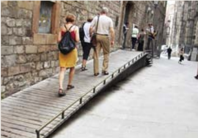
Rampe, Barcelona . Rampen er utformet slik at den kan demonteres uten at bygningen tar skade. Foto: Trondheim kommune
