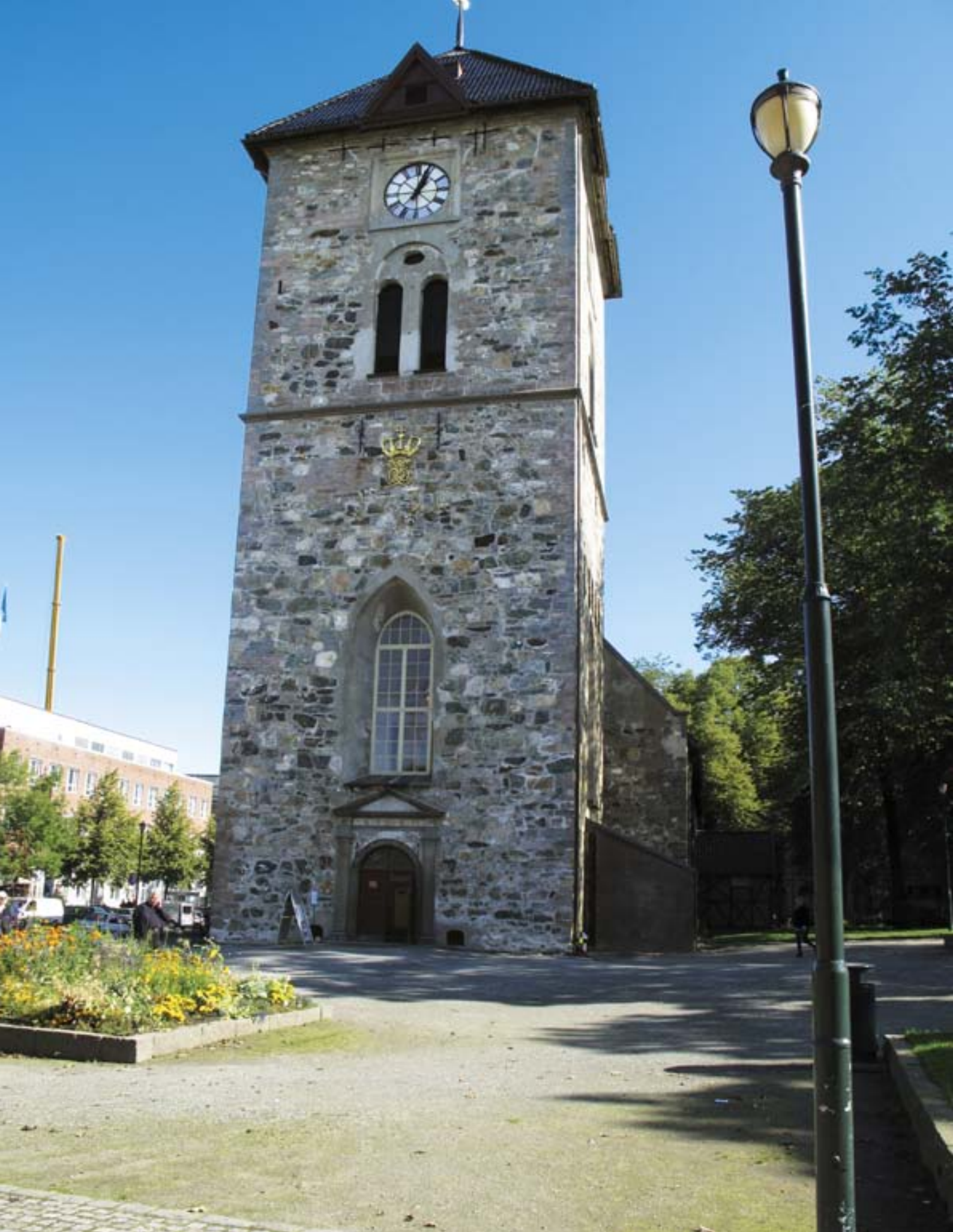
Terrenget ble hevet på plassen foran hovedinngang. Dette gir i dag trinnfri atkomst til kirken.
