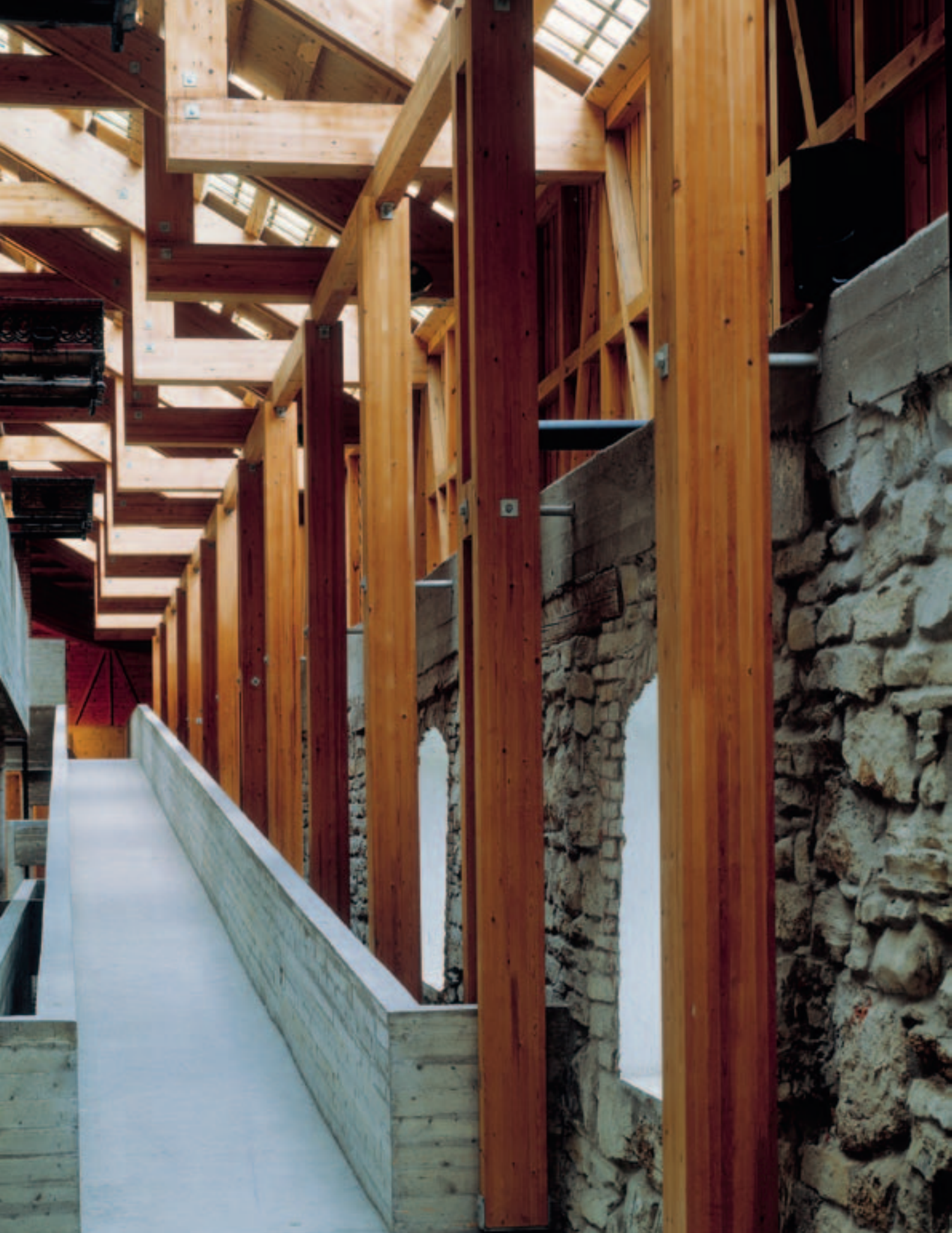
Storhamarlåven, Hamar Foto: Jiri Havran
