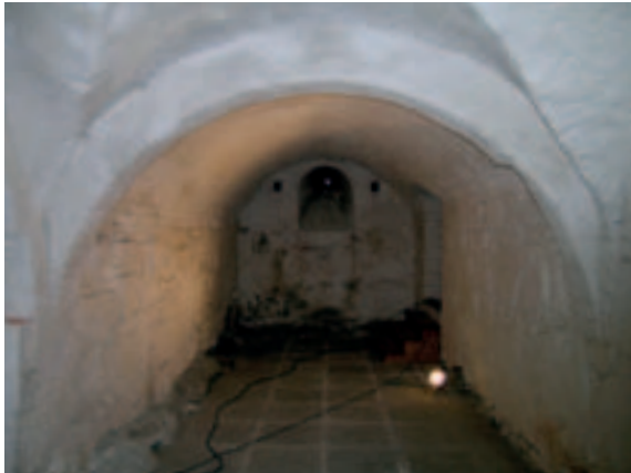
Forhvelvet før restaurering.
