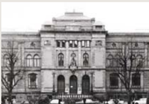
Utsnitt opprinnelig hovedfasade. Opprinnelig inngang med trapper opp fra hver side og tre monumentale dører.
