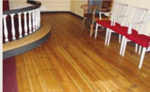
Teppe i korpartiet er fjerna, noko som har gitt eit betre inneklima.
