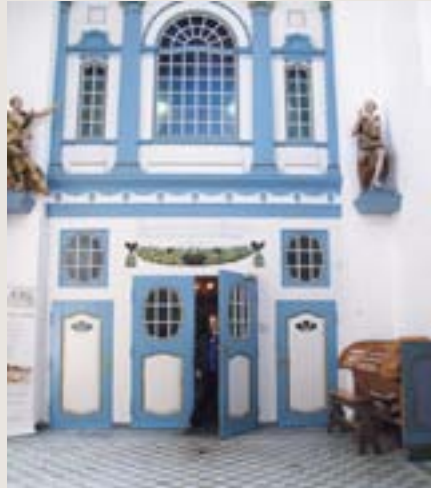
Trinnfri atkomst videre inn i kirken ved hjelp av innvendig rampe.
