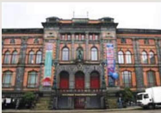
Utsnitt hovedfasade etter endring av hovedinngang til bakkenivå (1990). Repos er bevart og trappeløp endret. Gategrunnen er litt nedsenket.
