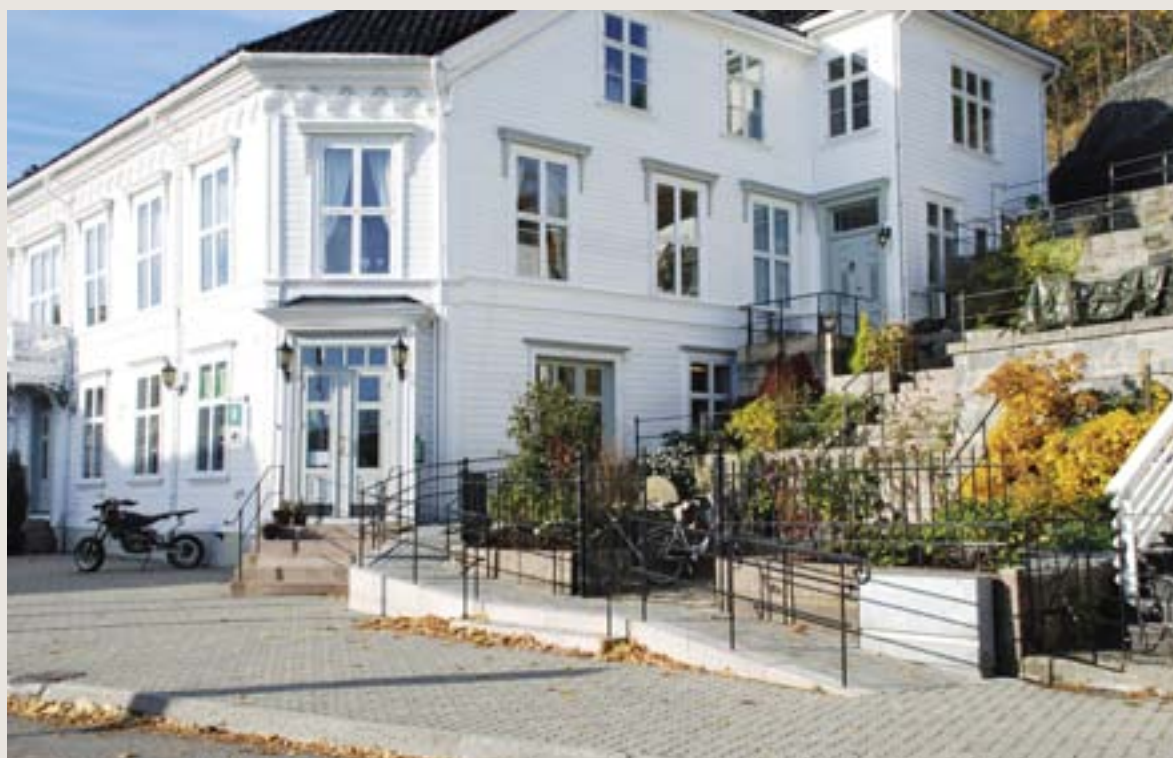
Ny rampe og inngang.
