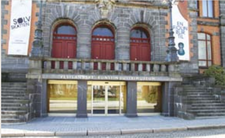
Utsnitt fra hovedfasade med gjennomført endring av hovedinngang med bedret belysning, glassdører med fotocelle-mekanisme og informasjonstavler tilpasset svaksynte. Foto: Bergen kommune
