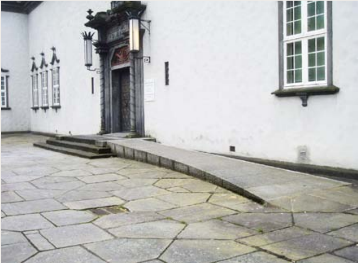
Ved Rasmus Meyers samlinger i Bergen er det liten nivåforskjell. Adkomst er løst på en estetisk tilfredstillende og funksjonell måte som ikke reduserer byggets antikvariske verdi. Foto: Bergen kommune
