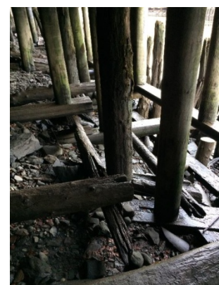
2014 Fundamenter under Kjøpmannsgata 13. Foto Byantikvaren i Trondheim 2014
