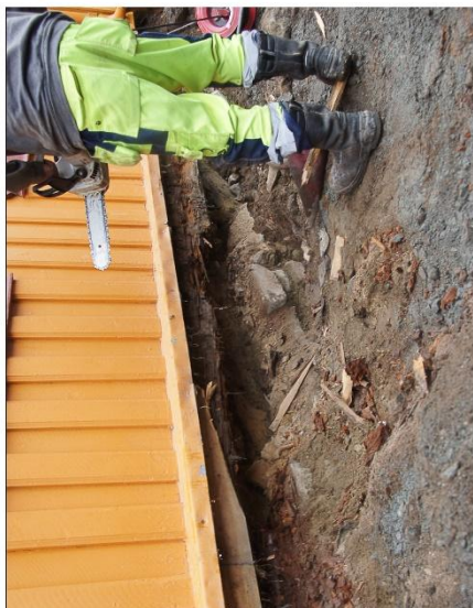
bergmannsgata 14_ tilstand 2014-002 I hjørne mot nord var det gjort en tidligere reparasjon med teglsten lagt i mørtel. Her er også 3.omfaret på langveggen noe råteskadd. Tre omfar av tverrvegg er også råteskadd.
