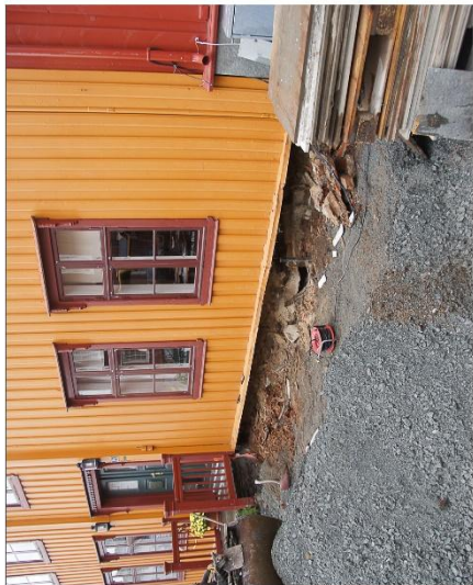
bergmannsgata 14_ tilstand 2014-001 Det som skulle ligge på moldbenk/dekke av grunnmur nemlig skiferstein (midtskjært Alta 18"firkansten) og 3 cm isopor er fjerna. Det samme er de to første omfarene som var sterkt råteskadd.
