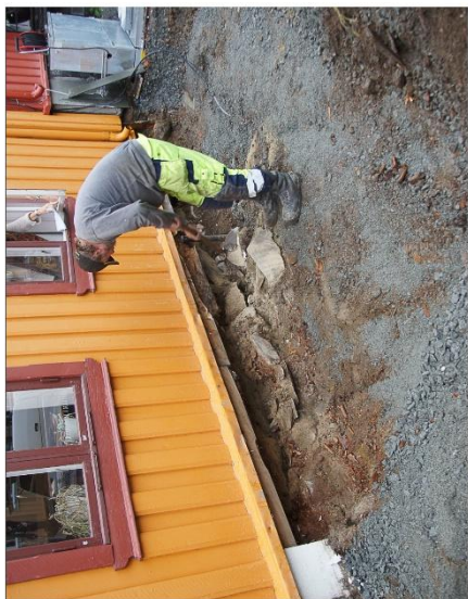
bergmannsgata 14_ tilstand 2014-001 Det som skulle ligge på moldbenk/dekke av grunnmur nemlig skiferstein (midtskjært Alta 18"firkansten) og 3 cm isopor er fjerna. Det samme er de to første omfarene som var sterkt råteskadd.
