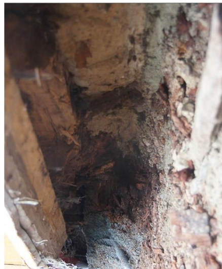
bergmannsgata 14_ tilstand 2014-007 Gulvbordene er 2 1/2". Over der er det et leirelag. Usikker konstruksjon men iallefall 15-25 cm opp til dagens eksisterende golv.
