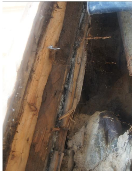
bergmannsgata 14_ tilstand 2014-007 Gulvbordene er 2 1/2". Over der er det et leirelag. Usikker konstruksjon men iallefall 15-25 cm opp til dagens eksisterende golv.
