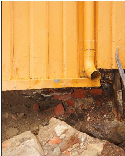
bergmannsgata 14_ tilstand 2014-002 I hjørne mot nord var det gjort en tidligere reparasjon med teglsten lagt i mørtel. Her er også 3.omfaret på langveggen noe råteskadd. Tre omfar av tverrvegg er også råteskadd.
