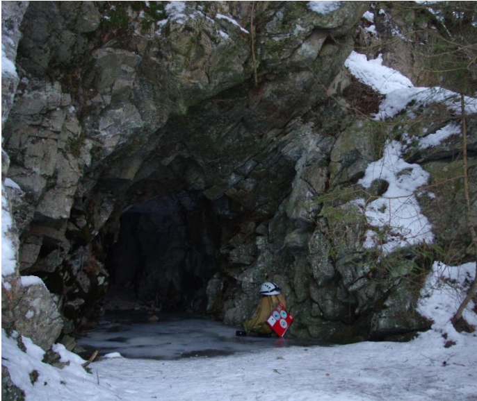
Fig. 12-1: Garnisonbekken tunnel. Vestre åpning.
