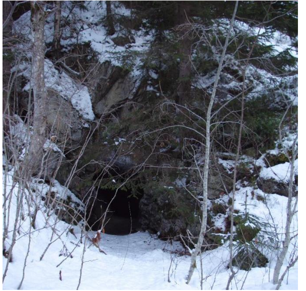
Fig. 12-2: Garnisonbekken tunnel. Østre åpning.
