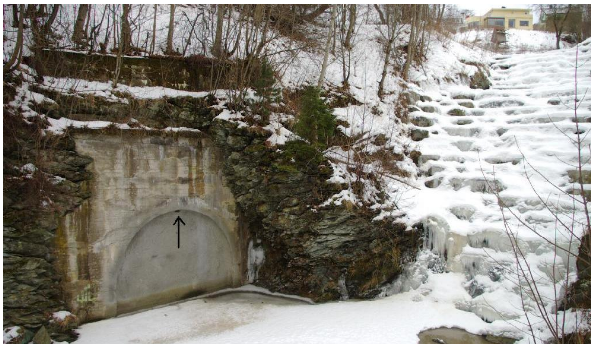
Avstengt jernbanetunnel ved Ilabekken. Hull laget for flaggermus markert med pil.
