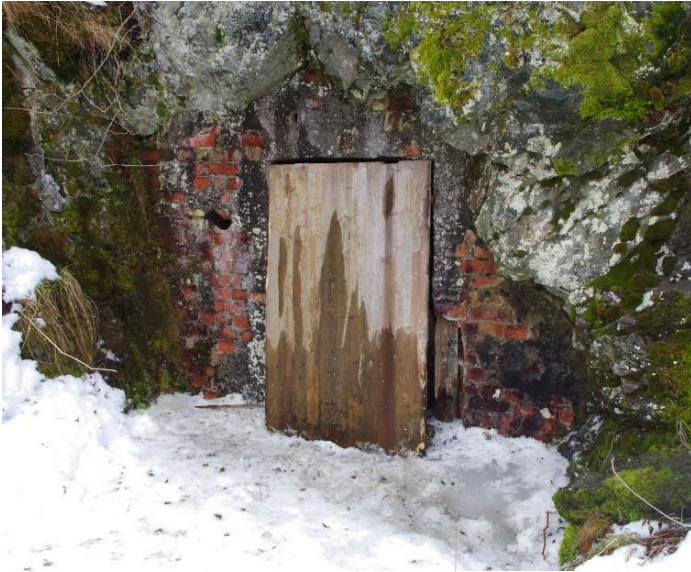
Fig. 3-1: Sverresborg – nordre tunnel. Inngang stengt med treplatt.
