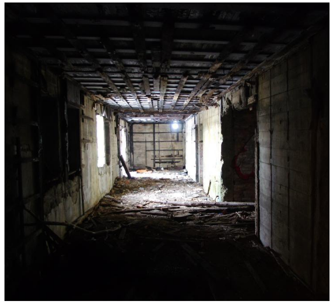
Fig. 17-2: Fra innsida av sørvestre bunker. For luftig og utsatt for frost.
