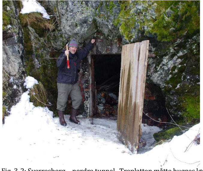
Fig. 3-2: Sverresborg – nordre tunnel. Treplatten måtte hugges løs fra isen.
