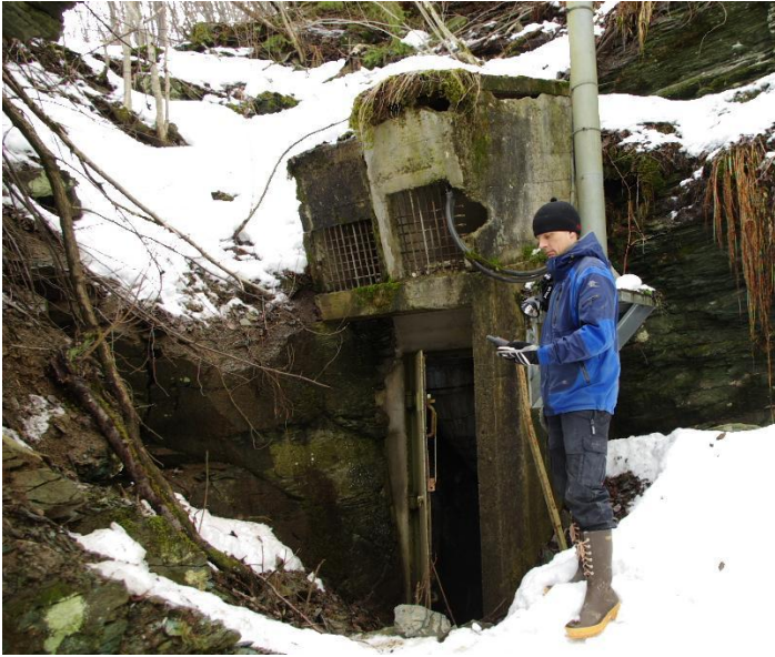
Fig. 8-1: Steinhaugen. Inngang til tunnelanlegget.
