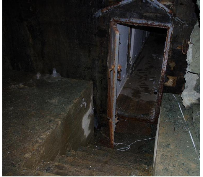
Fig. 8-2: Steinhaugen. Inngang til bunkerrom.
