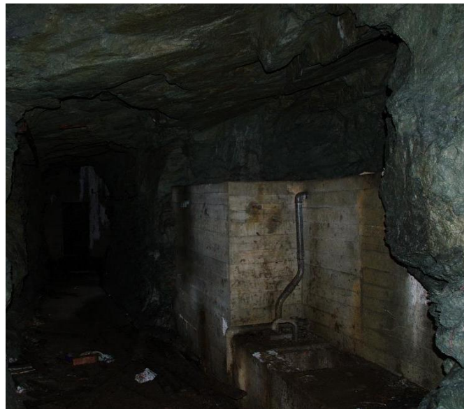
Fig. 2-4: Kystad tunnelanlegg. Betongkummer innerst i hallen. Tunnelen fortsetter inn til venstre.
