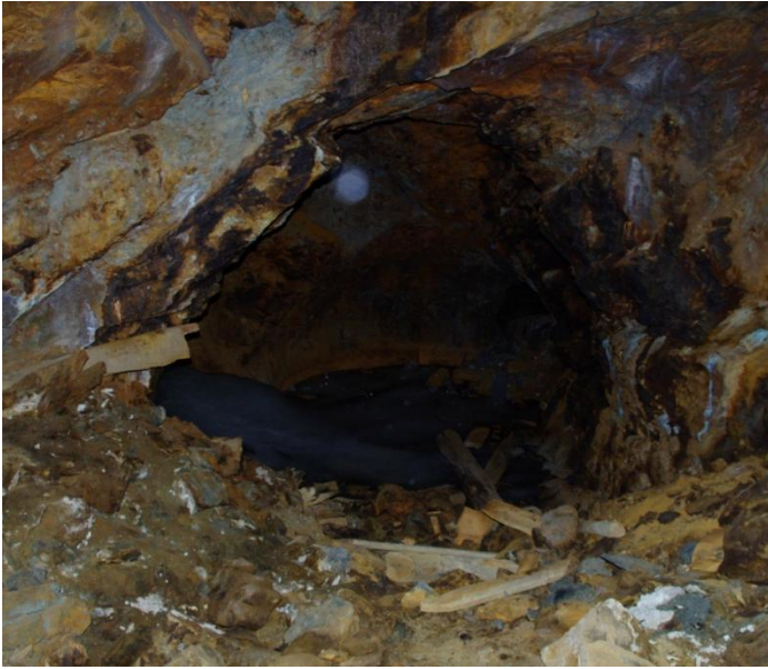
Fig. 1-5: Sjøla/Ulriksdal gruve vest: Nedgang til gruvegangen.
