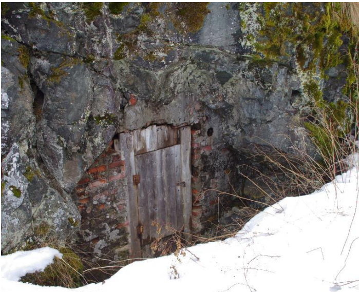
Fig. 3-3: Sverresborg – nordre tunnel. Inngang nr to, med luke i døra.
