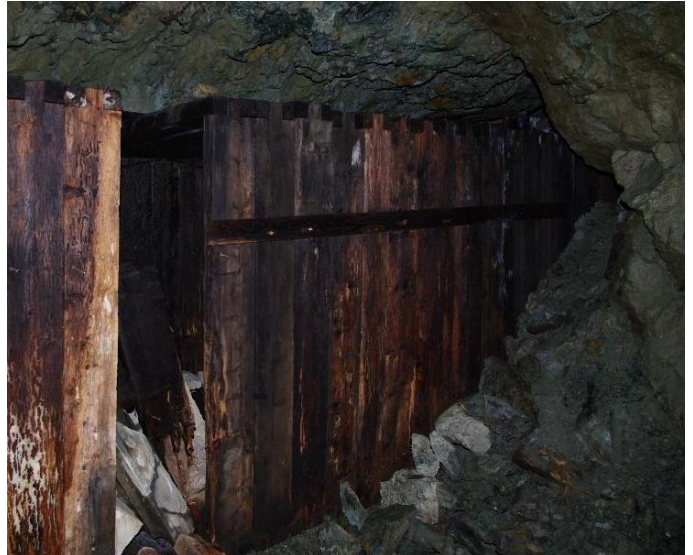
Fig. 4-2: Sverresborg – søndre tunnel. Innvendig tretunnel
