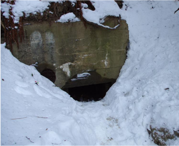
Fig. 2-1: Kystad tunnelanlegg. Inngang.
