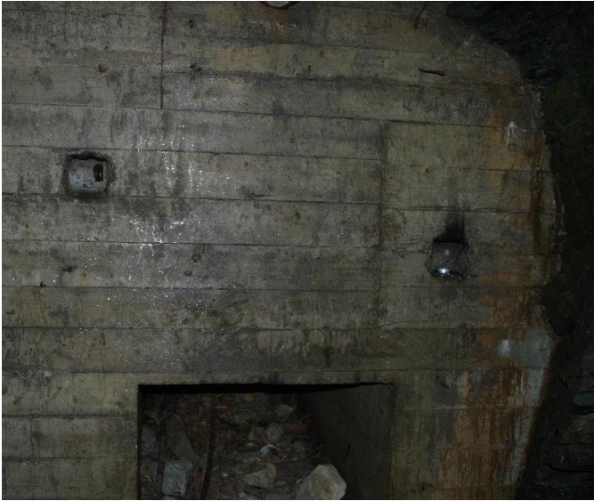
Fig. 2-5: Kystad tunnelanlegg. Betongvegg innerst i anlegget. Nordflaggermusa henger i gropa til venstre. Telys i gropa til høyre. Dette er trolig en utgang som er fylt igjen.
