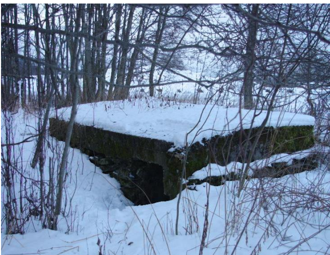
Fig. 26-1: Bunker Stavne. For frostsatt.
