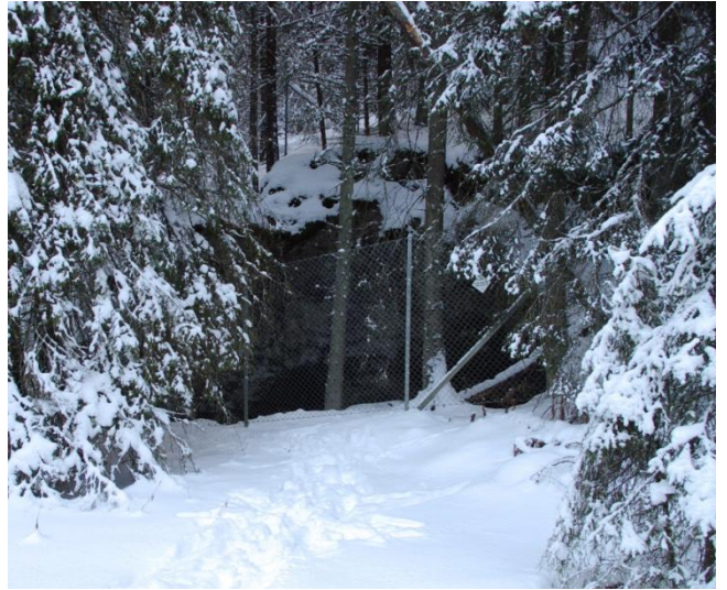
Fig. 1-2: Sjøla/Ulriksdal gruve vest: Øvre inngang.
