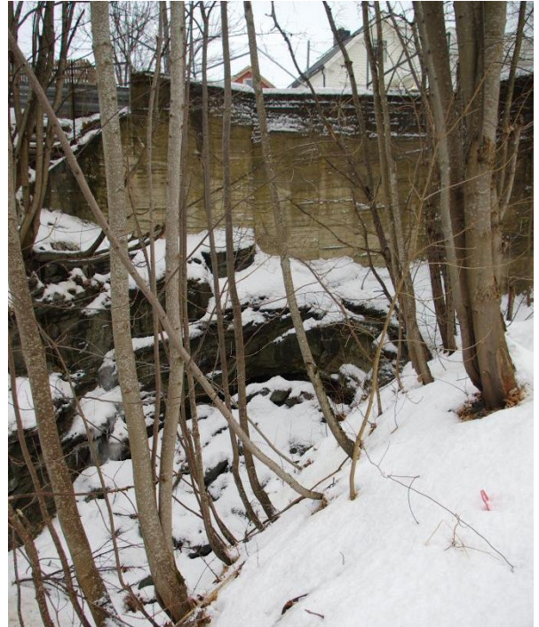
Fig. 10-2: Jernbanetunnel Ilabekken, vestre løp igjenmurt og helt stengt.
