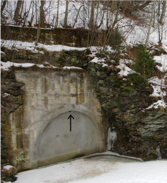
Fig. 10-1: Jernbanetunnel Ilabekken. Østre løp gjenmurt åpning med hull for flaggermus (pil).
