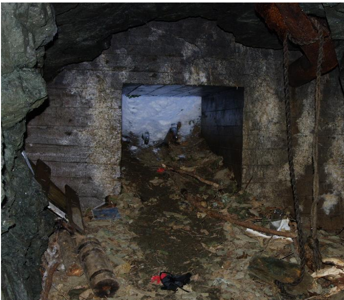
Fig. 2-3: Kystad tunnelanlegg. Inngang sett innenfra.
